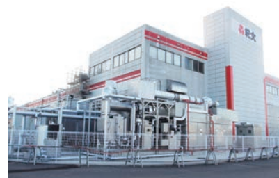
東京工場のガスコージェネレーションシステム
