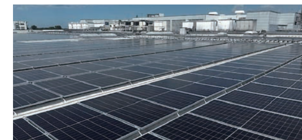
東京工場に設置工事の太陽光パネル
